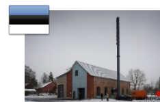
Kotelna na biomasu, Kohila Estonsko
